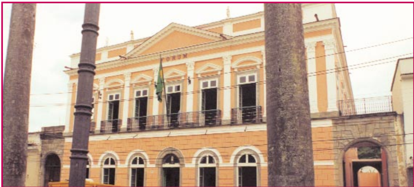
Antiga sede do Fórum, a Prefeitura de Vassouras foi reformada após o seminário
