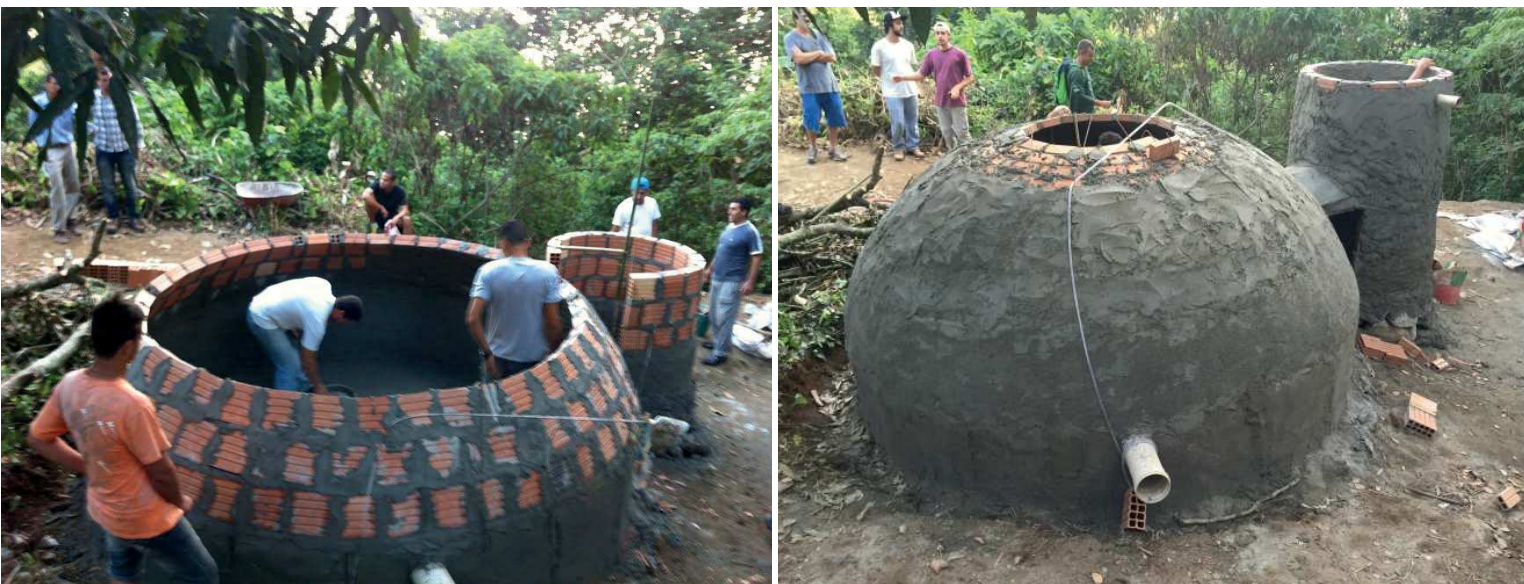
Equipe põe a mão na massa para construir o biossistema, que integra as etapas aeróbica e anaeróbica para tratar o esgoto do Vale Encantado
