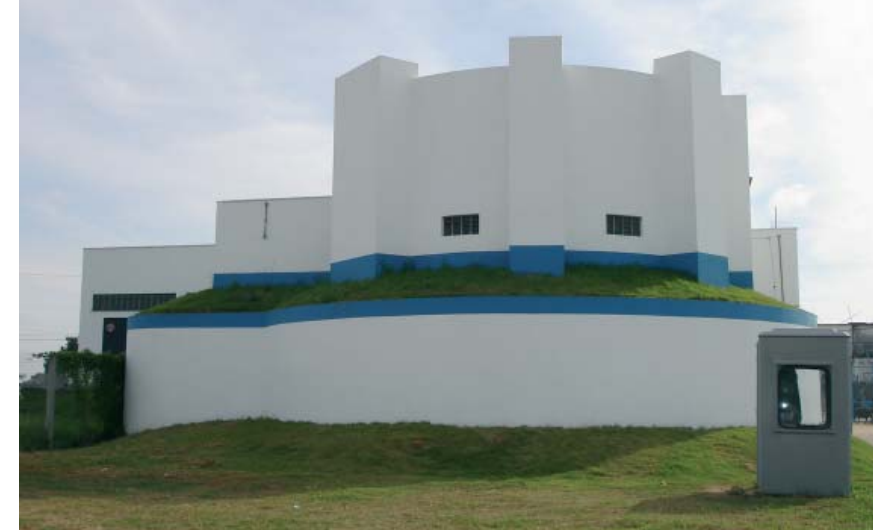
Campus da Uenf: equipamento ganhou prédio próprio, com 550 m 2 de área construída
