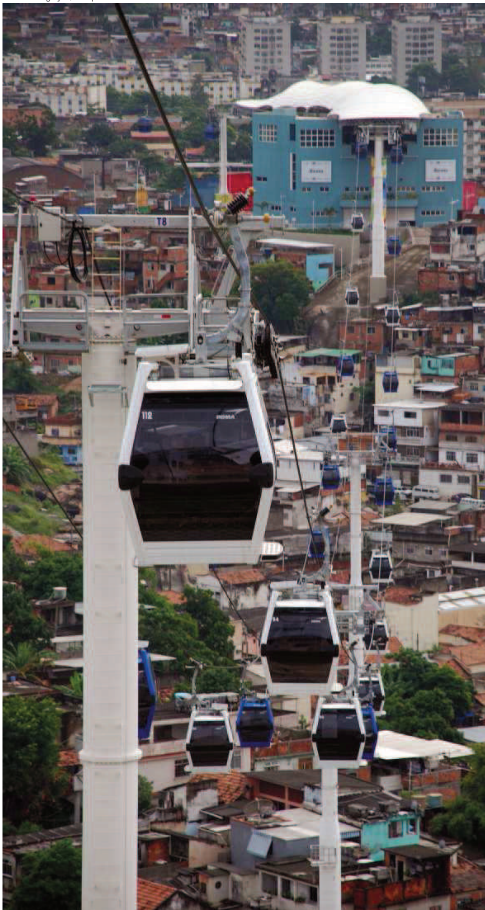
Teleférico do Complexo do Alemão, na Zona Norte: obra facilita o acesso diário de moradores
