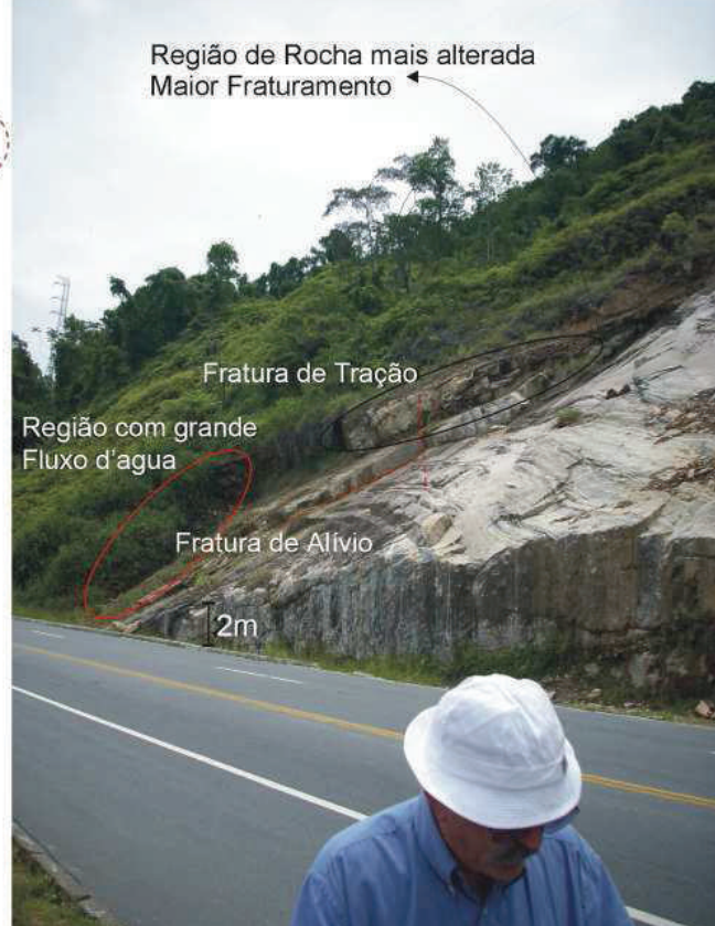
Setores críticos ao longo de estrada: à esq., no detalhe, blocos soltos com risco de queda; à dir., região de rocha alterada por fraturas
