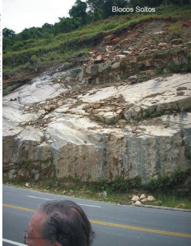
Setores críticos ao longo de estrada: à esq., no detalhe, blocos soltos com risco de queda; à dir., região de rocha alterada por fraturas
