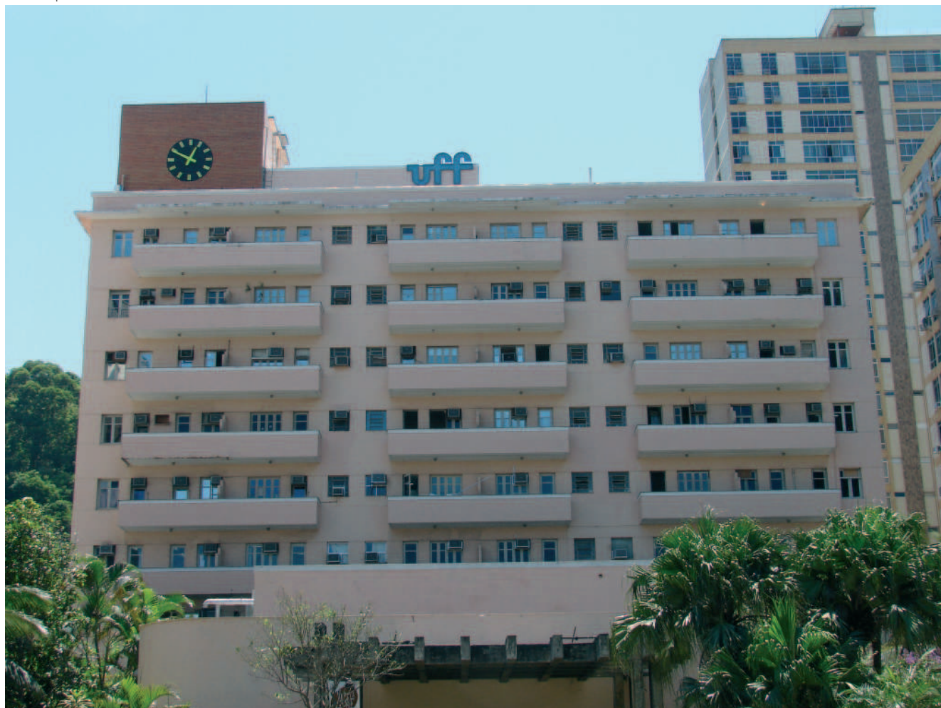
Antiga edificação do Hotel Balneário Cassino Icarahy abriga, desde 1967, a sede da reitoria da Universidade Federal Fluminense (UFF)
